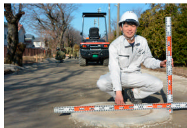
アスファルト舗装工事における測量中の筆者
