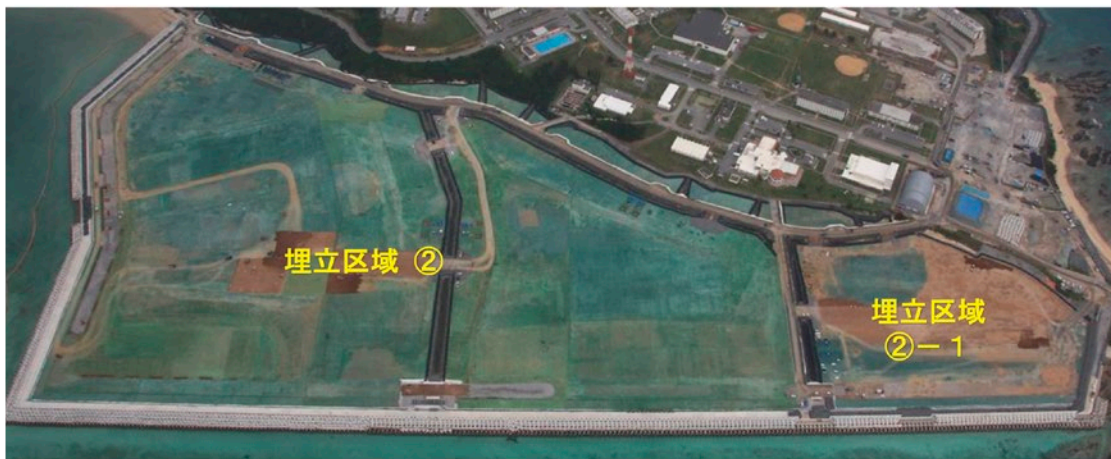
キャンプ・シュワブ南側の海域における埋立工事の進捗状況
